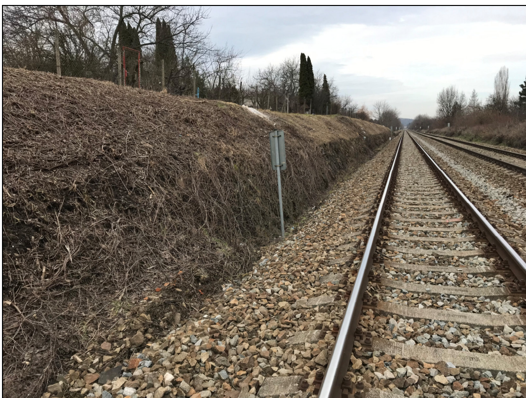
Obr. č. 7 Pohled na opěrnou zed' přesypanou zeminou
